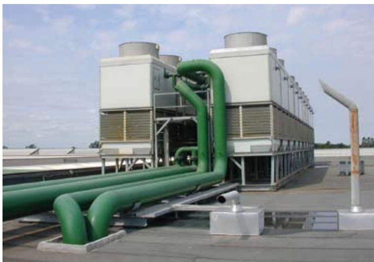
Vista del complesso di venti torri evaporative Mita destinate al raffreddamento di acqua per l'impianto di pastorizzazione
