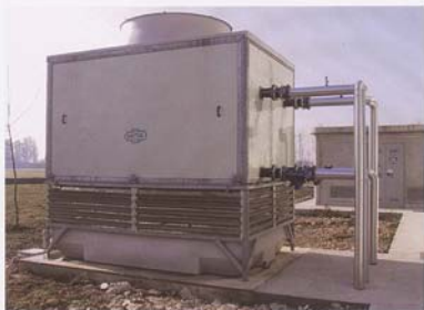
La torre evaporativa a circuito chiuso fornita da Mita per il raffreddamento delle pompe.
